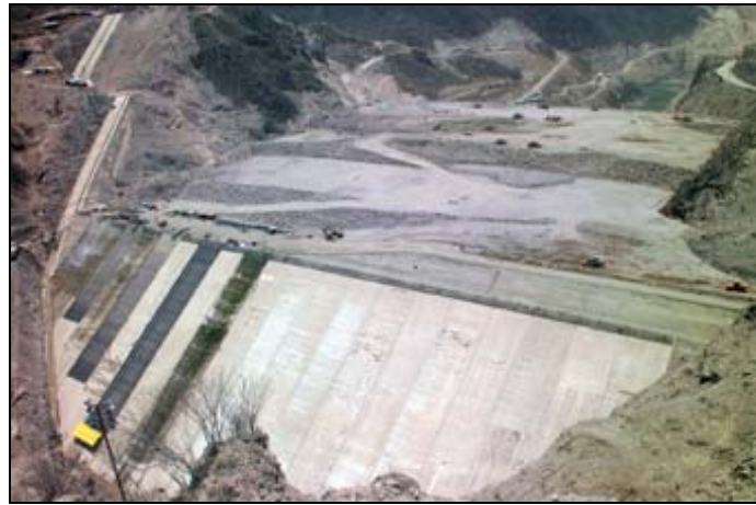
Ejecución de la capa asfáltica en la Presa de Ralco
