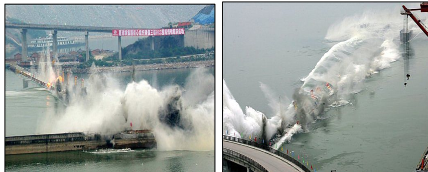
Dos momentos de la demolición (con explosivos) de una de las ataguías en la presa de las Tres Gargantas (China)
