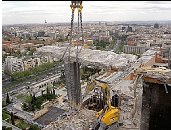
Derribo de una planta de un edificio
