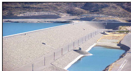
Presa heterogénea de pantalla impermeable
