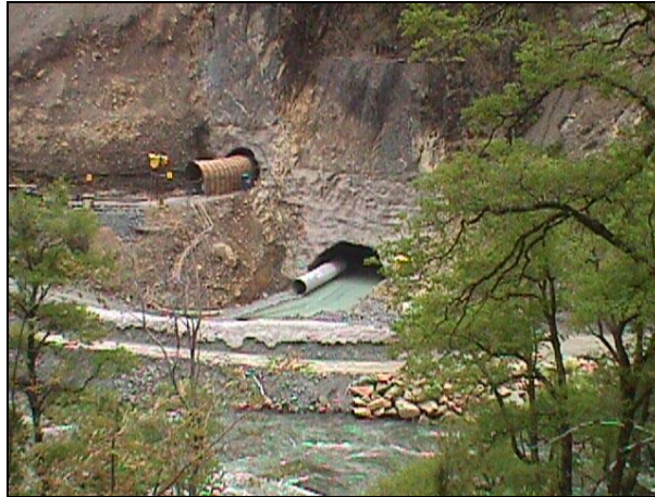
Túnel de desvío de la Presa de Ralco (Chile)
