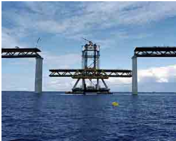
Colocación de elemento en el puente sobre el estrecho de Öresund
