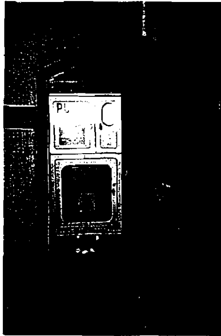
Nicho de seguridad. Túnel de Frejus (Francia)
