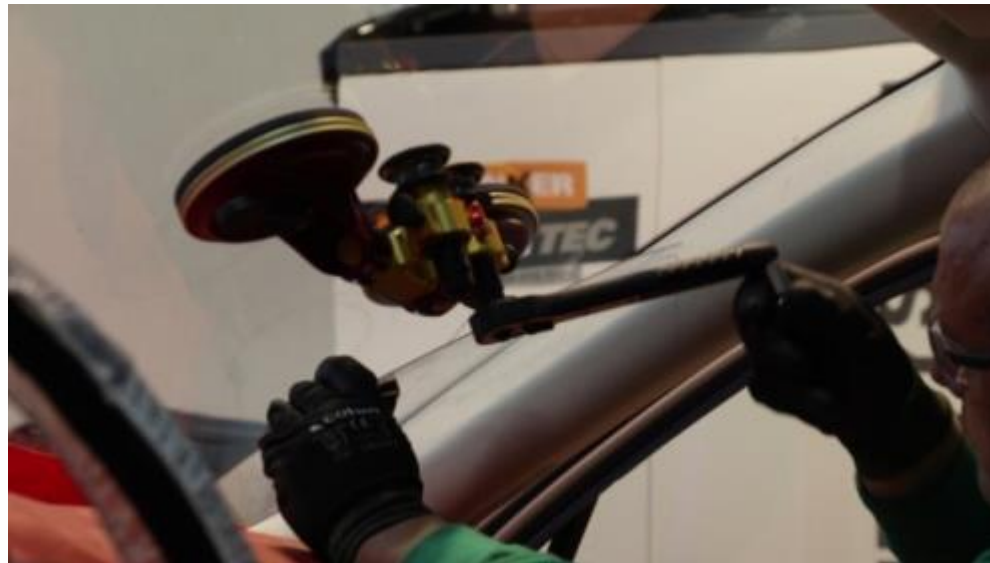
Operario realizando una sustitución de luna
