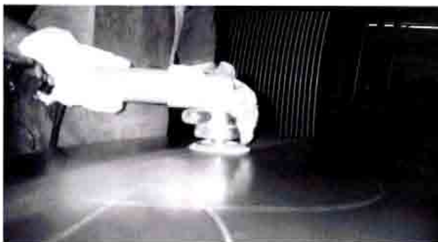
Pulido de techo con herramienta eléctrica horizontal.
