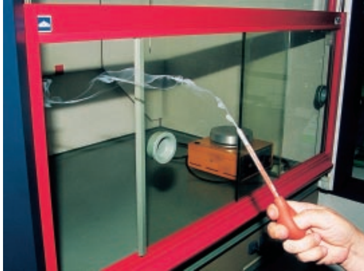
Ventilación forzada en una vitrina de laboratorio
