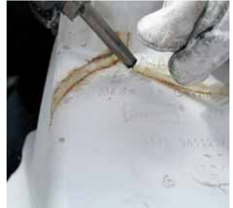
► Soldadura con varilla de aportación
