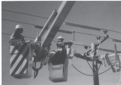
Figura 9.6. Trabajo en equipo (trabajo bajo tensión)
