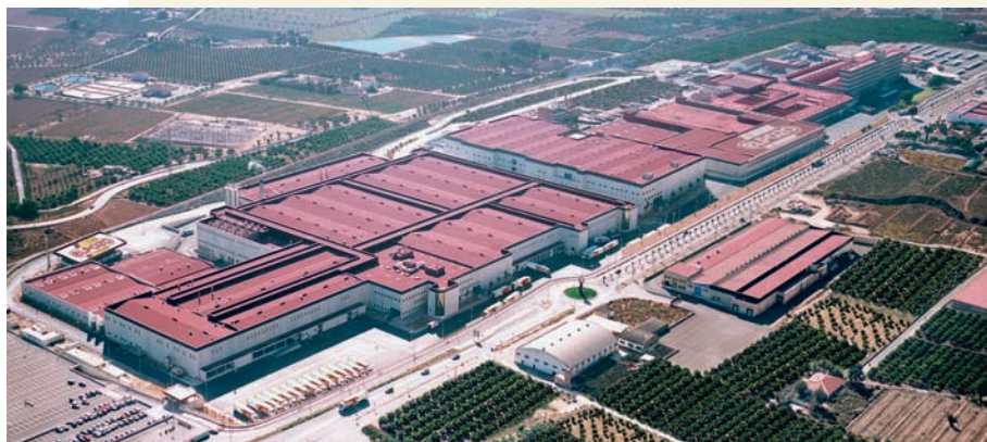
Sede de ElPozo Alimentación, buque insignia de Grupo Fuertes, en Alhama de Murcia.
