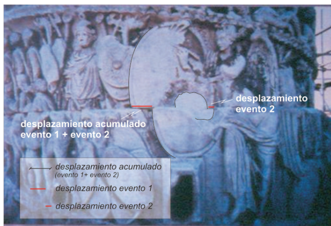
Figura 7.33. Zona inferior de la Columna de Adriano (Roma). En esta columna se observan como mínimo dos rotaciones de los tambores de la columna producidos por eventos sísmicos. El segundo rota una zona que reparada de la columna (zona derecha imagen). En la parte izquierda se puede observar el desplazamiento relativo de los dos de los tambores de la columna, muy visible en la parte inferior del escudo. Este desplazamiento es el desplazamiento acumulado de al menos dos eventos: el evento 2, y como mínimo un evento anterior (evento 1) (Foto: Teresa Bardaji).
