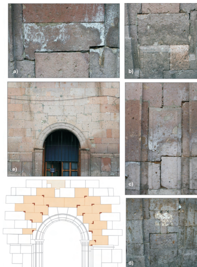
Figura 8.34. Ejemplos (a, b, c y d) de la complejidad en el diseño de alguno de los engatillados inventariados en la ciudad de Morelia (México) en el antiguo mesón de San Agustín (siglo XVII). e) foto y esquema de una de las puertas de este edificio.
