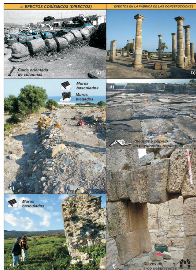
Figura 8.19. Efectos cosísmicos en la fábrica de las construcciones inventariados en el yacimiento romano de Baelo Claudia (Cádiz, España). a) Caída orientada de columnas afectando a los muros de la basilica en la zona del Foro de Baelo Claudia (Silleries, 1997). En muchos casos es necesario consultar el material original de las excavaciones arqueológicas para poder definir los diferentes efectos correctamente. b) En este caso, la zona de la basilica ha sido restaurada, situando a las columnas en su posición original antes del colapso. c) Fragmento de muralla oriental de la ciudad plegada y basculada . En algunas ocasiones podemos encontrar dos efectos en una misma estructura. d) pliegues y pop up en el enlosado regular de la plaza del Foro. e) Fragmento de la muralla occidental basculada . f) dovelas hundidas y desplazadas en una ventana adintelada en uno de los edificios públicos del Foro.
