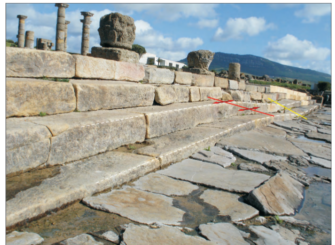
Figura 7.37. Bordillos plegados de la escalera entre la Basílica y el Decumanus Maximus en Baelo Claudia (Cádiz). La metodología de análisis de la deformación es similar a la utilizada en los pavimentos plegados (ver figura 7.6).
