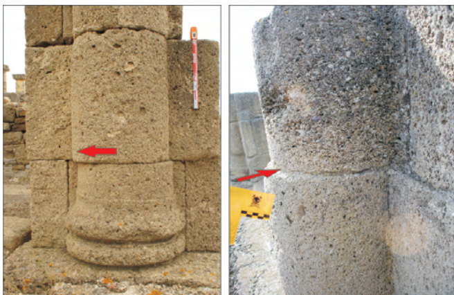
Figura 7.36. Desplazamientos de sillares con cierto grado de libertad de movimientos, ya que son las estructuras terminales de los muros que separan las diferentes tiendas del macellum (mercado) ( Baelo Claudia , Cádiz). Este tipo de desplazamientos se pueden analizar como vectores (L3), ya que se puede cuantificar la magnitud del movimiento relativo entre los dos bloques.
