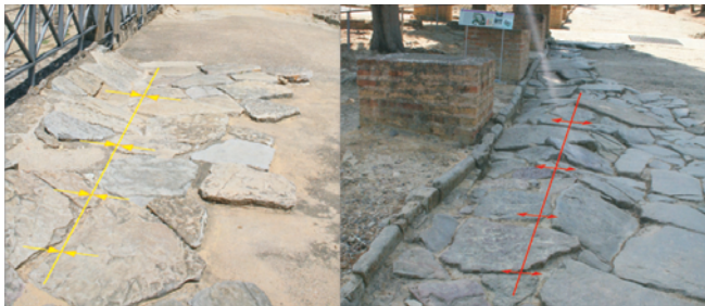
Figura 7.48. Enlosados irregulares plegados en el yacimiento romano de Itálica en Santiponce (Sevilla, España). Las estructuras plegadas parecen estar relacionadas con el sistema de alcantarillado subterráneo que discurre debajo de las calles. La ausencia de otros efectos claros en el yacimiento, no permite asignar estas deformaciones a un origen sísmico.
