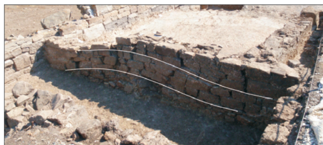
Figura 7.17. Ejemplo de un muro plegado en el yacimiento romano de Baelo Claudia (Cádiz, España) con inmersión del eje menor de 45^\circ . La falta de libertad del muro en su movimiento se resuelve con el plegamiento de la estructura muraria.
