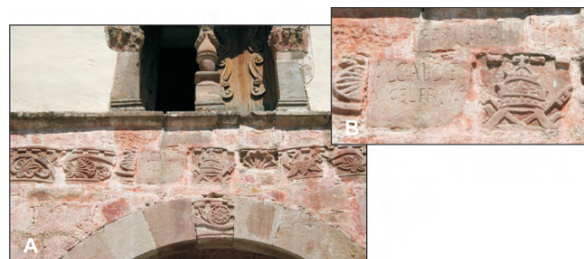
Figura 8.36. Reconstrucción de los daños de una iglesia de principios del siglo XIX (Patzcuaro, México) producidos como consecuencia del terremoto del Pátzcuaro de 1856. En la imagen se observa como se reutilizaron las dovelas del arco de la puerta principal como sillares del muro frontal de la iglesia. También se observa la colocación invertida del sillar que mostraba el año de construcción de la iglesia (1823).
