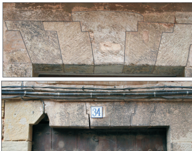
Figura 8.6. Detalles de las estructuras de sillares engatillados en dinteles de puertas en la zona del casco antiguo de la población de Navarrete (La Rioja, España).
