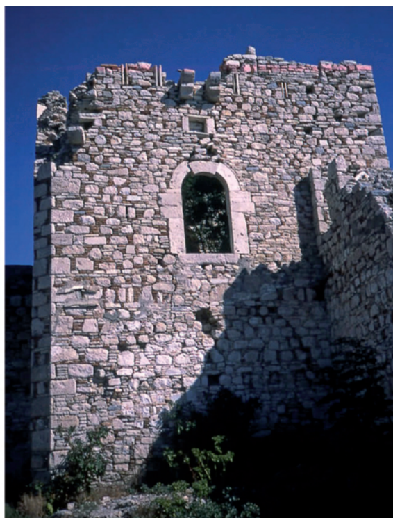
Figura 6.12. Efectos cosísmicos en la fábrica de las construcciones (deformaciones instantáneas a la vibración). Los movimientos horizontales inducidos por terremotos producen la separación de las dovelas, eliminando el soporte de lateral de las mismas, produciendo el movimiento vertical (deslizamiento) de las dovelas, generalmente la clave del arco. En la foto se puede observar el colapso de la clave del arco de una ventana en un fortificación del siglo XIX en Pythagorion (Samos, Grecia) como consecuencia de un terremoto de magnitud 6.9 ocurrido en 1955 (Stiros, 1996) (Foto: T. Bardaji).
