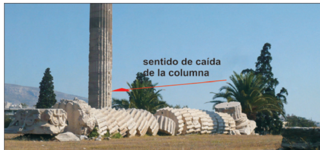
Figura 7.28. Orientación de caída de la columna. Podemos considerar esta orientación paralela a la dirección de máximo acortamiento horizontal (ey). La direccionalidad del daño queda definida sentido de caída de la columna. Templo de Zeus (Atenas, Grecia)(fotografía cedida por Virginia Ruiz Villanueva).
