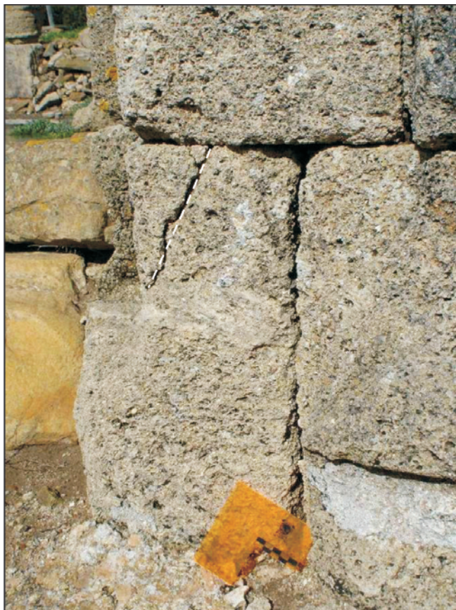
Figura 7.30. Estructura de rotura en la esquina de un bloque situado en el macellum (mercado) del yacimiento romano de Baelo Claudia (Cádiz, España).
