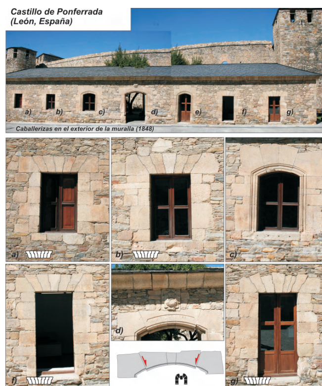
Figura 8.3. Dinteles engatillados en puertas y ventanas de las caballerizas del Castillo de Ponferrada (León, España). En la fachada de este edificio, datado en 1845, se observa la utilización de engatillados en las dovelas de puertas (f y g) y ventanas (a y b). Estos dinteles pueden ser materiales reutilizados de estructuras anteriores del castillo, ya que a mediados del siglo XIX y propiciado por el propio ayuntamiento, se produjo un expolio sistemático de la sillería del castillo para su utilización en diferentes obras civiles. d) Hundimiento de dovelas en la puerta central.
