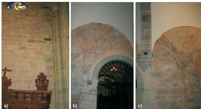
Figura 8.10. Efectos post sísmicos: a) reconstrucción de un muro en una de las capillas laterales. Nótese el cambio de color de la sillería utilizada en la reconstrucción, así como la utilización de sillares engatillados para reforzar la estructura y disminuir las cargas horizontales inducidas por sismicidad. b) y c) Reconstrucción del claustro en 1755 con posterioridad al terremoto. Se observan las marcas de la estructura previa colapsada por el terremoto.
