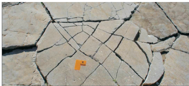
Figura 7.9. Ejemplos de fracturas conjugadas en losas de los pavimentos en el yacimiento romano de Baelo Claudia (Cádiz, España): en el pavimento del Decumanus Maximus (izquierda) y en el enlosado de la Plaza del Foro (derecha). Este tipo de efectos deben ser considerados de forma global en el yacimiento, es decir deben analizarse gran cantidad de losas para considerarlos estadísticamente representativos en el análisis de la deformación de un yacimiento arqueológico (nota: la escala naranja que aparece en estas y en otra fotos es de 10X10 cm).
