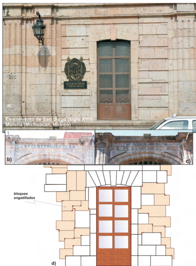
Figura 8.33. a) Detalle de la reconstrucción (1884) de la fachada del ex convento de San Diego con aplicación de medidas constructivas sismorresistentes; (b) la reconstrucción del mismo data de finales del siglo XIX (1895) (c) posterior al gran terremoto de Pátzcuaro de 1856 que asoló las poblaciones de Pátzcuaro y Morelia. En la reconstrucción de la fachada se observa la utilización sistemática de sillares engatillados (d).
