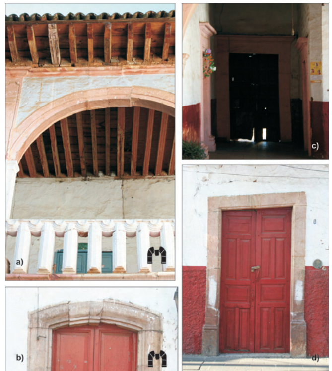
Figura 8.38. En la ciudad de Patzcuaro se pueden observar algunas estructuras cosísmicas posiblemente relacionadas con el terremoto de 1856, no obstante la falta de una datación inequívoca nos hace imposible la asignación clara de estos efectos al evento. a) y b) Movimientos verticales de las dovelas en arcos. c) y d) En muchos casos el adobe se comporta de forma menos rígida frente a la deformación que las estructuras de sillería, lo que produce que las estructuras de adobe sufran deformación por cizallamiento, deformación muy evidente en las estructuras más rígidas contenidas en esos muros (e.g. marcos de madera en puertas (c), dinteles de sillería (d)).
