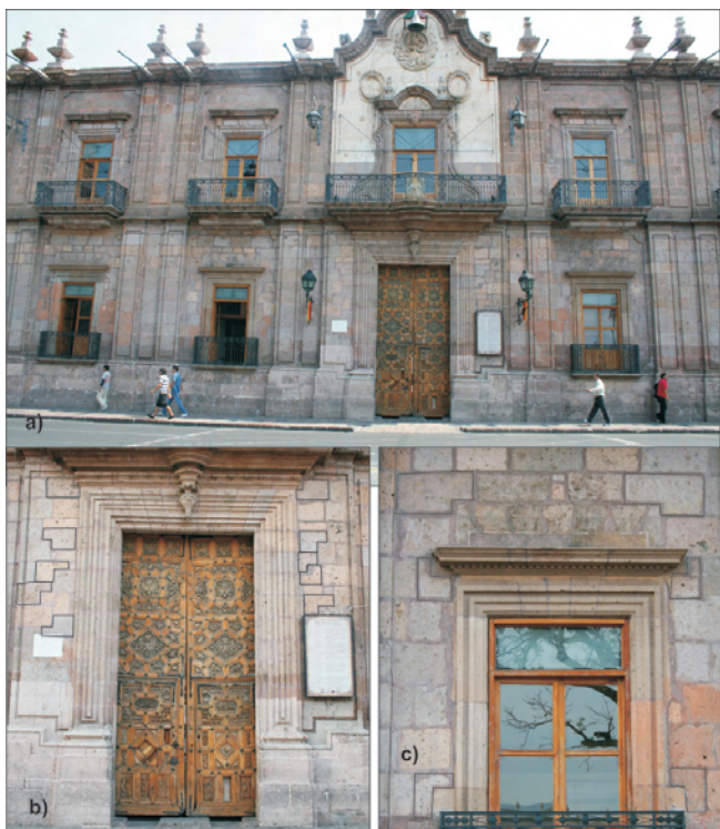
Figura 8.30. a) Fachada principal del Palacio de Gobierno de la ciudad de Morelia (Michoacán, México) (1760-1770). En este palacio barroco se observa la utilización sistemática de sillares engatillados en puertas y ventanas en la planta baja del edificio. b) Detalle de la puerta principal del palacio. c) Detalle de una de las ventanas con engatillados en la parte superior e inferior. Esta distribución de engatillados en las ventanas se observa en la misma posición en prácticamente todas las ventanas de la planta baja del edificio.
