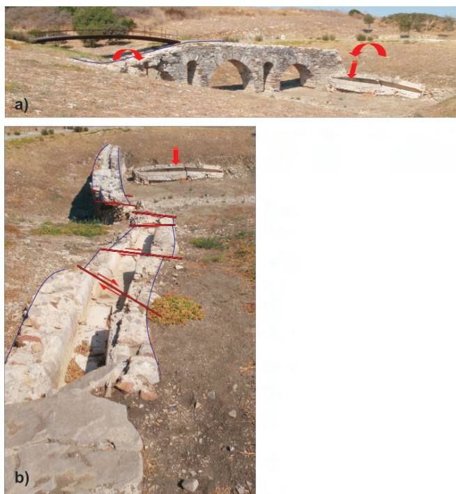
Figura 7.22. Acueducto desplazado en el exterior de la muralla este de la ciudad romana de Baelo Claudia (Cádiz, España). Esta estructura de distribución de agua está desplazada en uno de sus extremos por una serie de pequeñas fracturas en dirección de carácter fundamentalmente diestro. Al fondo se puede ver una parte del acueducto que ha colapsado. La interpretación de esta estructura está condicionada al análisis detallado del subsuelo, ya que estos desplazamientos pueden estar asociados a movimientos permanentes del terreno que pueden tener su origen en diferentes procesos (e.g. movimientos sísmicos, deslizamientos).
