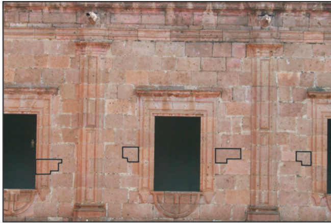
Figura 8.29. Ejemplo de la sistematicidad y simetría en la utilización de engatillados en el patio interior del Palacio de Clavirejo (finales del XVIII y principios del XIX) (Morelia, México). Estas estructuras suelen estar relacionadas con ventanas y puertas, para evitar su colapso por cizalla en caso de movimientos horizontales de origen sísmico.
