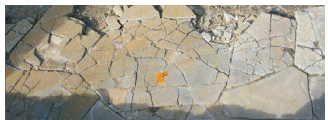
Figura 7.9. Ejemplos de fracturas conjugadas en losas de los pavimentos en el yacimiento romano de Baelo Claudia (Cádiz, España): en el pavimento del Decumanus Maximus (izquierda) y en el enlosado de la Plaza del Foro (derecha). Este tipo de efectos deben ser considerados de forma global en el yacimiento, es decir deben analizarse gran cantidad de losas para considerarlos estadísticamente representativos en el análisis de la deformación de un yacimiento arqueológico (nota: la escala naranja que aparece en estas y en otra fotos es de 10X10 cm).
