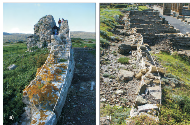
Figura 7.19. Ejemplos de muros plegados (inmersión de los ejes mayor de 45^\circ ) en el yacimiento de Baelo Claudia (Cádiz, España). a) Muralla este de la ciudad, en las proximidades del único bastión que permanece en pie (foto realizada desde el sur). b) Muros de la zona de tiendas en la plaza del foro (foto realizada desde el norte). En ambos casos se observa que además de presentar un plegamiento evidente, estas estructuras murarias están basculadas hacia el oeste.
