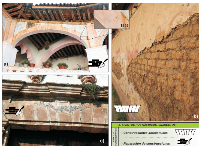
Figura 8.37. Estructuras post sísmicas de la ciudad de Patzcuaro. a) estructura de reconstrucción de arcos en una de las casas de la plaza. En la parte superior izquierda del arco se observa la inscripción de la fecha de reconstrucción de la estructura (1859), tres años después de la ocurrencia del terremoto. b) Estructura de construcción sismorresistente en un muro de adobe, para reforzar estos muros frente a deformaciones horizontales se incluía una capa de caña que le daba mayor consistencia frente a las deformaciones paralelas al plano de muro. Nótese que se ha sustituido en una parte por tela metálica. c) Reparación de un dintel en una de las puertas del museo de la ciudad.
