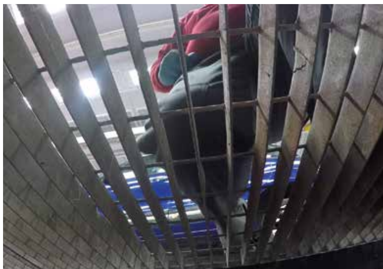
► Enrejillado del área de pintura
