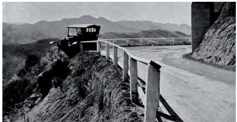
Contención primitiva de vehículos en una carretera
