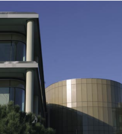
Nuevo edificio de MAPFRE SEGUROS GENERALES en Majadahonda (Madrid)
