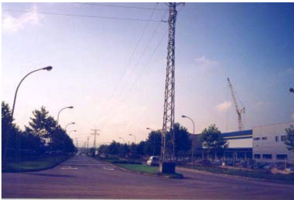
Poste eléctrico sin proteger
