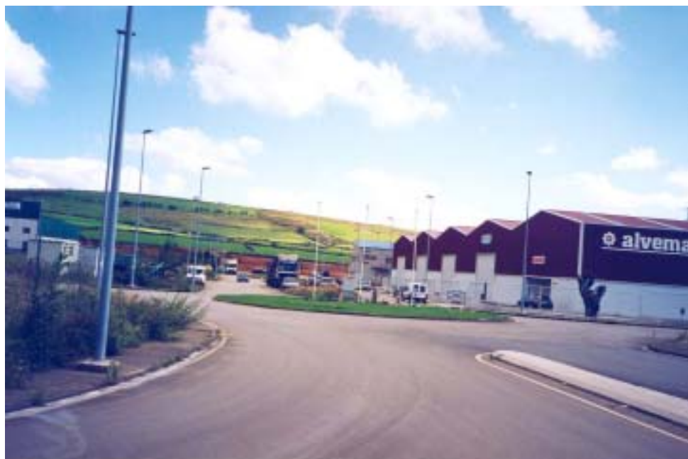
Ausencia de balizamiento y de la señal de advertencia de glorieta
