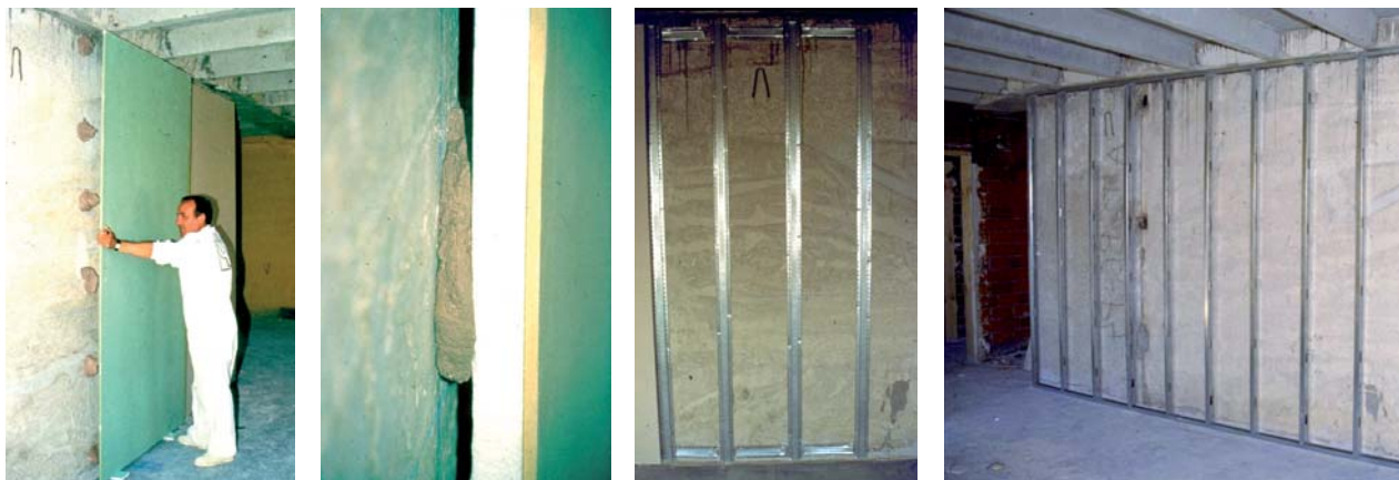
Colocación de paneles industrializados.
