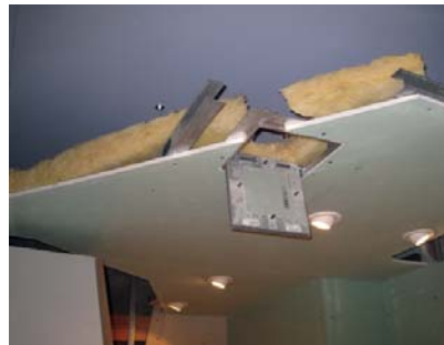
Falso techo en los pasillos y rozas verticales en los paramentos.
