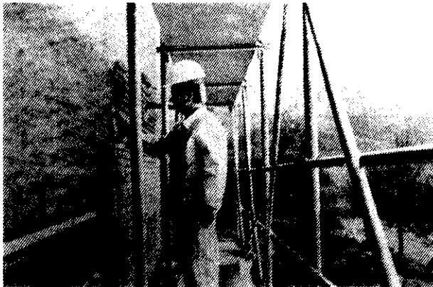
Revoque de paramentos exteriores desde un andamio tubular.
