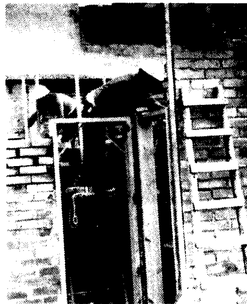
Formación paredes interiores de carga desde andamio de borriquetas.
