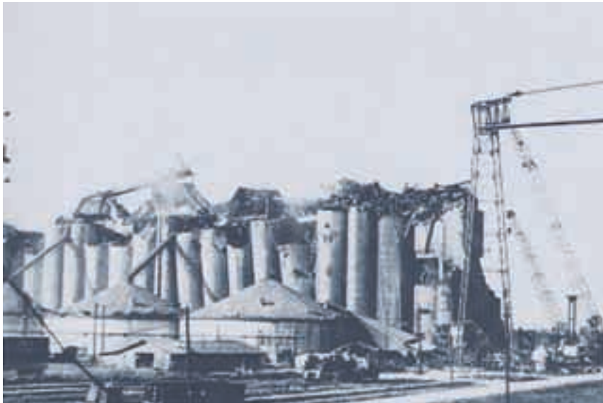
Explosión de silos de grano en Lousiana (Estados Unidos) el 22 de diciembre de 1977. Fuente: Laboratorio Oficial J. M. Madariaga.
