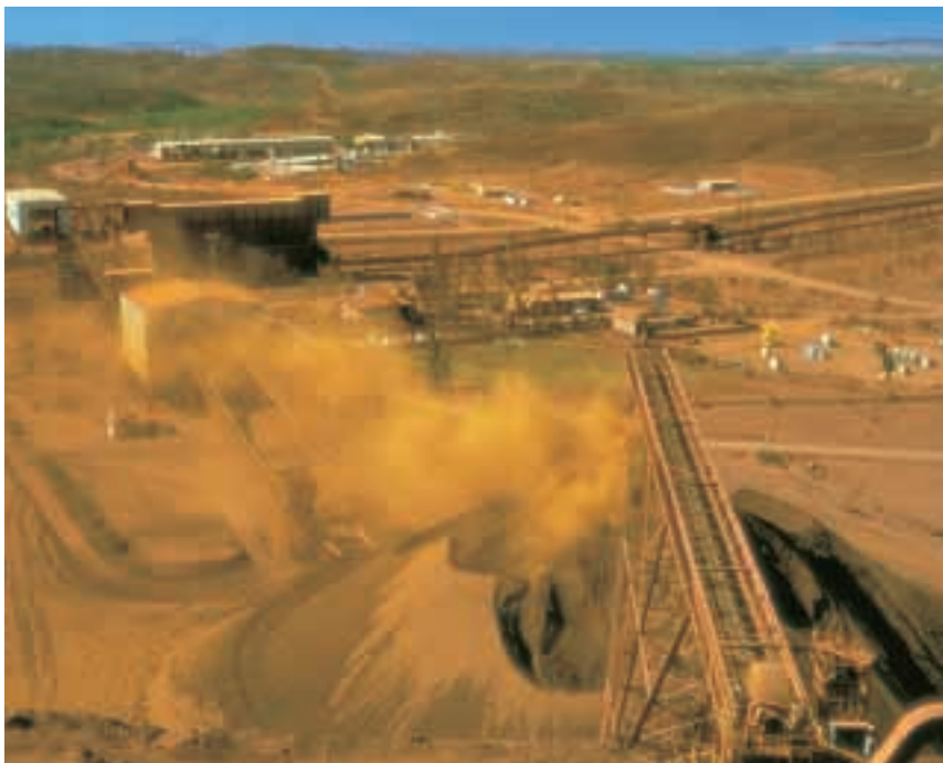
Vista panorámica de las cintas de alimentación del molino.
