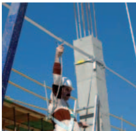
Fotos 9 y 10. Operario suspendido de una línea de anclaje con el Sistema SIP.
