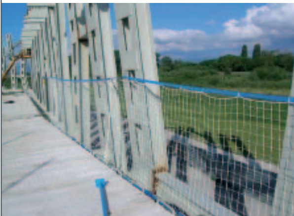
Fotos 34 a 39. Obras con implantación del Sistema SIP como protección colectiva.
