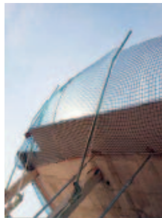
Fotos 34 a 39. Obras con implantación del Sistema SIP como protección colectiva.
