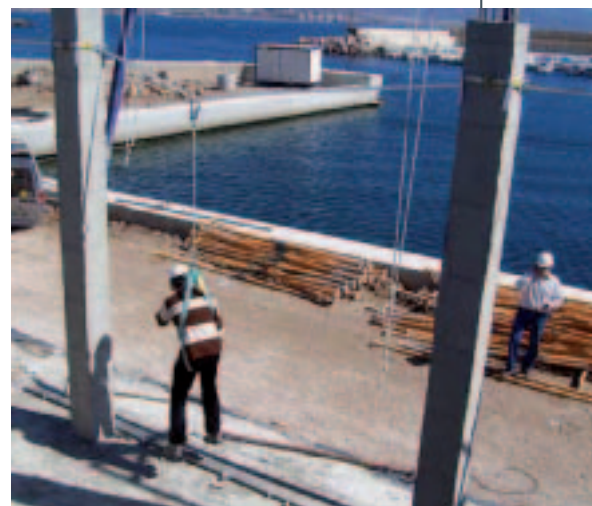
Fotos 9 y 10. Operario suspendido de una línea de anclaje con el Sistema SIP.
