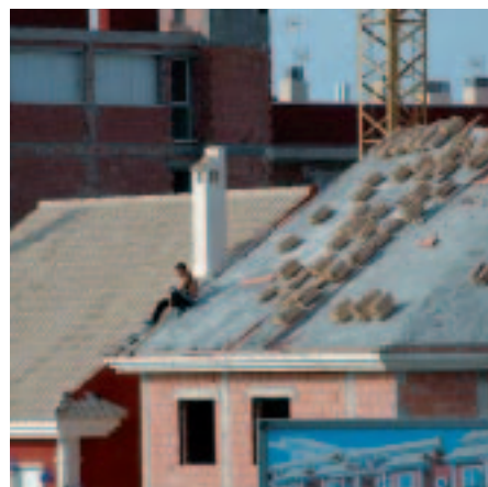
Fotos 17 y 18. Dos ejemplos del elevadísimo riesgo de caída a distinto nivel en forjados inclinados.
