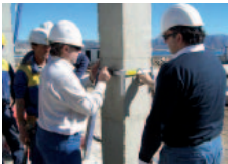
Fotos 1 y 2. Fijación del anclaje a un pilar de hormigón y tensado del sistema.
