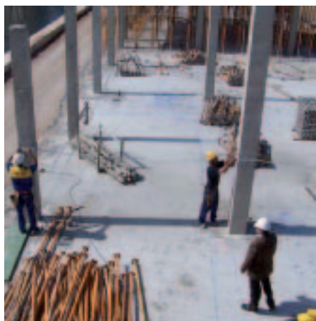
Fotos 6, 7 y 8. Instalación de una línea de anclaje o línea de vida de 14 metros de longitud.
