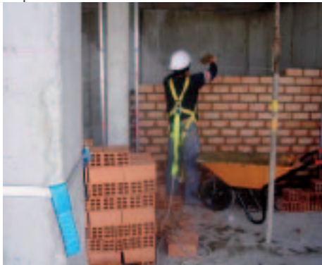
Fotos 11 a 16. Situaciones de obra donde se utiliza el Sistema SIP: durante la colocación y retirada de protecciones colectivas; la ejecución del cerramiento desde el interior; los trabajos en andamios de borriquetas; la recepción de cargas en plataformas de carga y descarga, etc.
