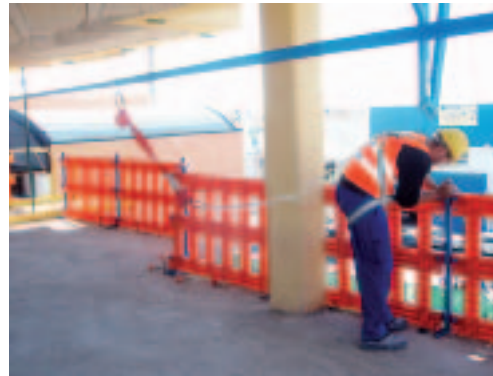
Fotos 11 a 16. Situaciones de obra donde se utiliza el Sistema SIP: durante la colocación y retirada de protecciones colectivas; la ejecución del cerramiento desde el interior; los trabajos en andamios de borriquetas; la recepción de cargas en plataformas de carga y descarga, etc.
