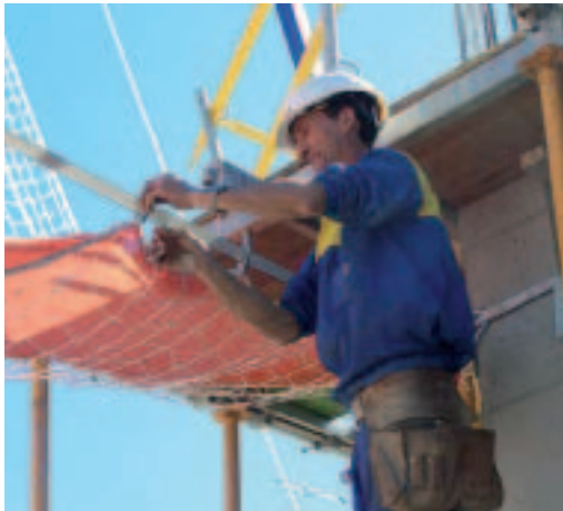
Fotos 25, 26 y 27. Instalación de redes de seguridad del sistema V entre las horcas y los pilares, con posibilidad de incorporar un protector acolchado abrazando a la horca metálica.
