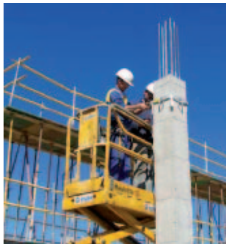
Fotos 23 y 24. Tensado de la cinta desde uno de los extremos, de forma que quede lo más rígida posible.
