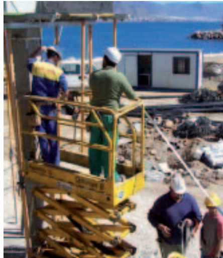
Fotos 21 y 22. Fijación de una cinta o un cable de acero desde un extremo a otro pasando por los mosquetones de todos los dispositivos.
