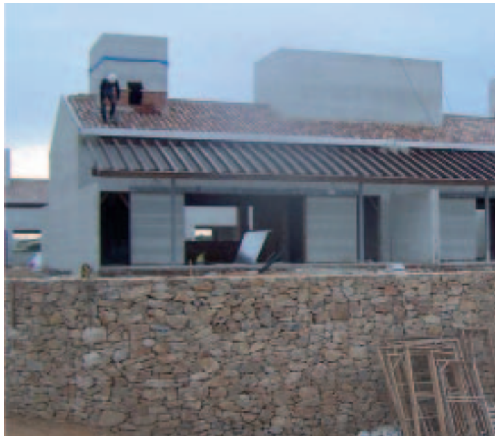
Foto 5. Empleo del Sistema SIP en un voladizo de un forjado en plantas elevadas.
