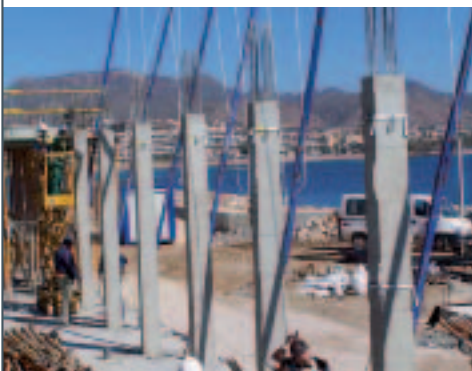
Fotos 19 y 20. Instalación del Sistema SIP en todos los pilares perimetrales de la zona a proteger.
