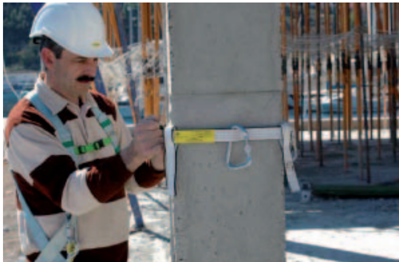
Fotos 1 y 2. Fijación del anclaje a un pilar de hormigón y tensado del sistema.
