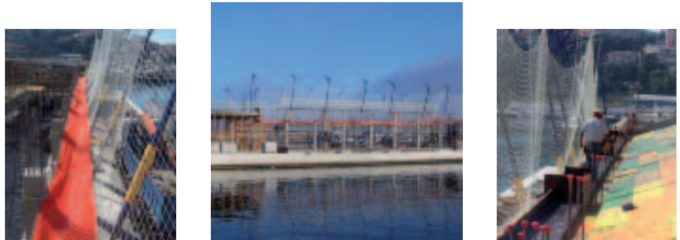
Fotos 25, 26 y 27. Instalación de redes de seguridad del sistema V entre las horcas y los pilares, con posibilidad de incorporar un protector acolchado abrazando a la horca metálica.
