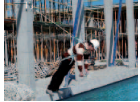
Fotos 3 y 4. El operario, una vez fijado el anclaje a un punto resistente, puede sujetarse al Sistema SIP con total seguridad.
