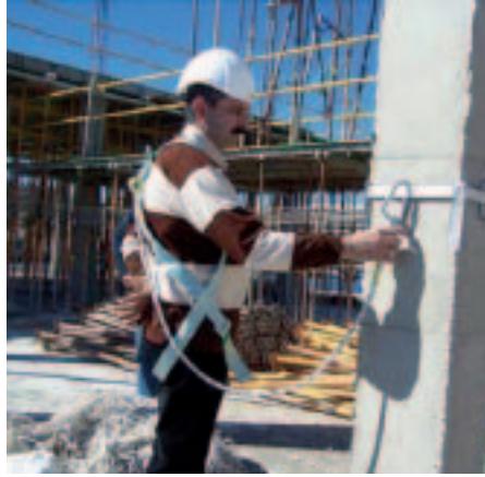
Fotos 3 y 4. El operario, una vez fijado el anclaje a un punto resistente, puede sujetarse al Sistema SIP con total seguridad.
