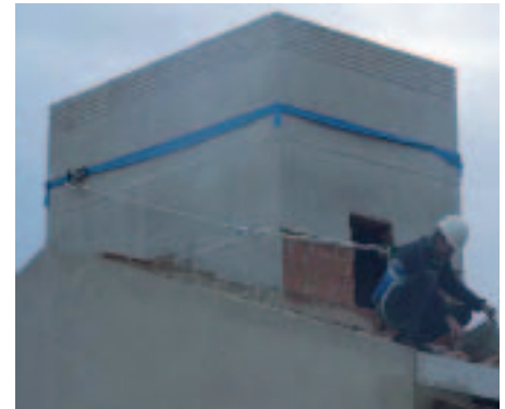
Fotos 11 a 16. Situaciones de obra donde se utiliza el Sistema SIP: durante la colocación y retirada de protecciones colectivas; la ejecución del cerramiento desde el interior; los trabajos en andamios de borriquetas; la recepción de cargas en plataformas de carga y descarga, etc.
