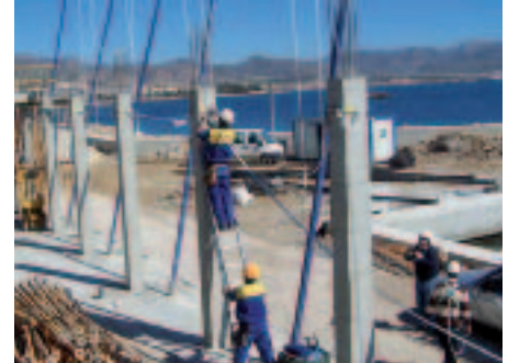
Fotos 21 y 22. Fijación de una cinta o un cable de acero desde un extremo a otro pasando por los mosquetones de todos los dispositivos.
