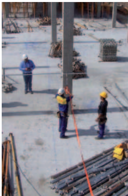
Fotos 6, 7 y 8. Instalación de una línea de anclaje o línea de vida de 14 metros de longitud.
