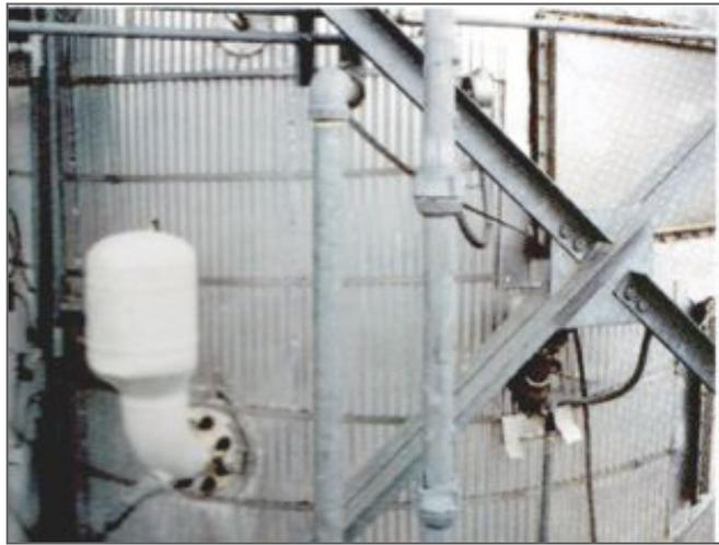
Sistema de protección en equipo de proceso mediante supresión
