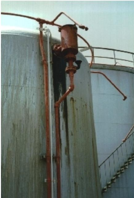
El equipo instrumental y/o eléctrico puede verse expuesto al efecto de la corrosión. Este efecto se pone de manifiesto rápidamente mediante una degradación progresiva de varios años, dependiendo del nivel de corrosividad, de las posibles combinaciones sinérgicas entre los gases contaminantes y las condiciones climatológicas existentes.
