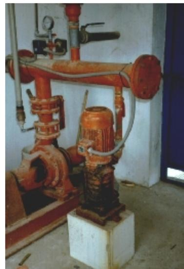
En maquinaria a la intemperie, sin protección, especialmente en zonas cercanas al litoral provoca agarrotamiento de partes móviles, rotura o avería de la misma.
