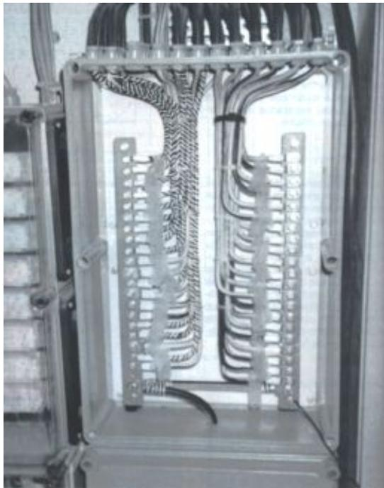
Fig. 8. Embarrado de puesta a tierra
