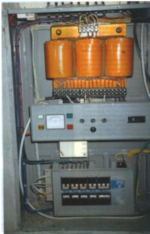
Fig. 9. Transformador de aislamiento y dispositivo detector de fugas
