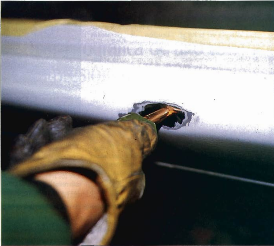
Soldadura de clavos.
