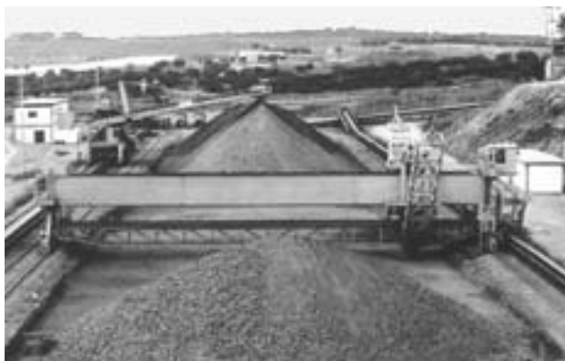
Figura 4. Parque de minerales con el equipo de apilado y recogida (Fuente: ENUSA)
