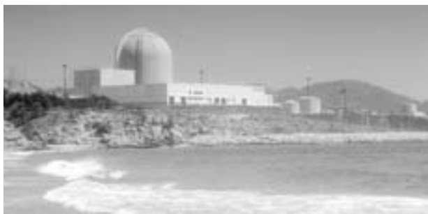
Figura 9. Central Nuclear de Vandellós II
