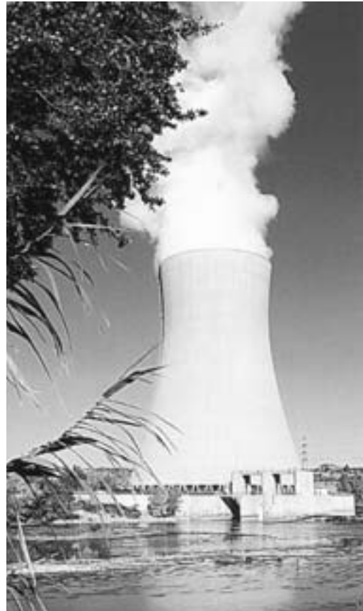
Figura 5. Torre de refrigeración de tiro natural
