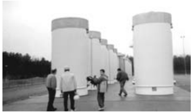
Figura 6. Almacén Temporal en Seco de combustible gastado (Surry – EE.UU.)
