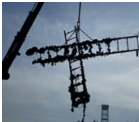
Limpieza de fondos marinos en el puerto de Fisterra.
