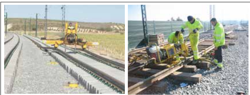
Figura 4. Posicionado y apriete del carril
