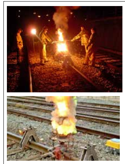
Figura 9. Reacción durante la soldadura aluminotérmica
