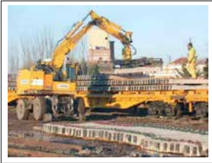
Figura 1. Descarga de las traviesas
