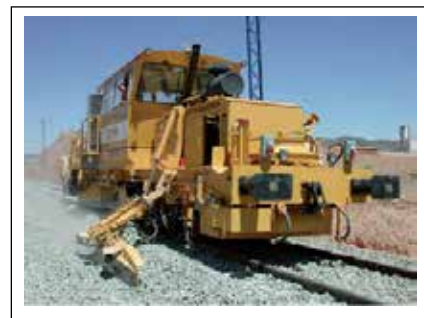
Figura 6. Perfilado del balasto
