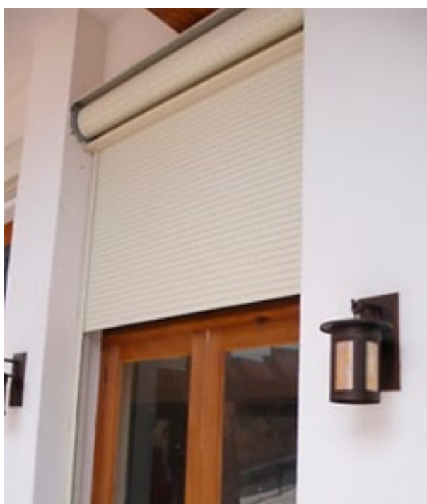
Esta persiana anticiclónica impidió la rotura del ventanal del recinto.
