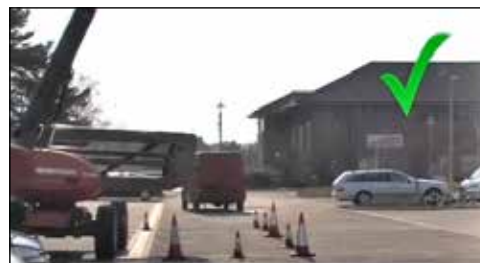
Figura 20. Delimitación de zona de trabajo.
