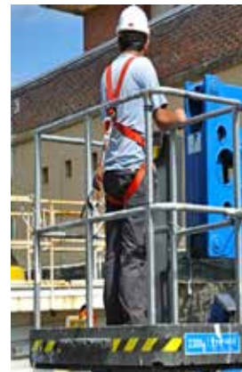
Figura 18. Operario con arnés y eslinga ajustable.
