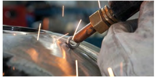
► Reparación de depósito
