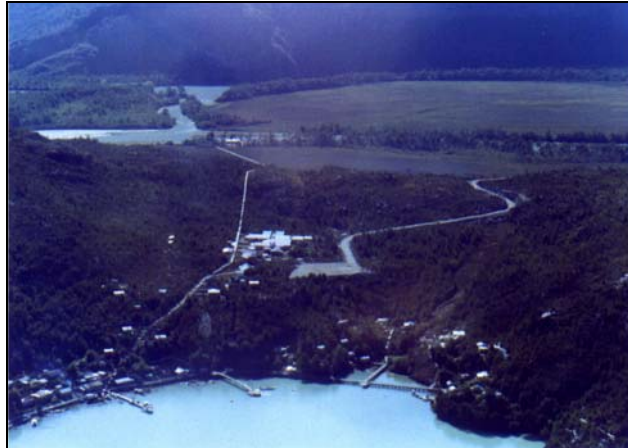
Entorno de una obra
