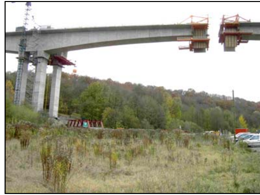
Construcción de puente en voladizo desde pilares
