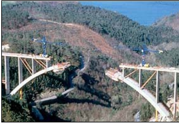
Construcción de puente desde estribos. Arriostramientos diagonales provisionales de sujeción (zonas amarillas)
