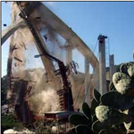
Derrumbe del andamiaje metálico en las obras de la autovía del Mediterráneo en Almuñécar (Granada)
