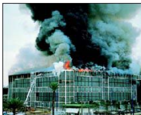
Incendio del Pabellón de los Descubrimientos. Expo -92 Sevilla
