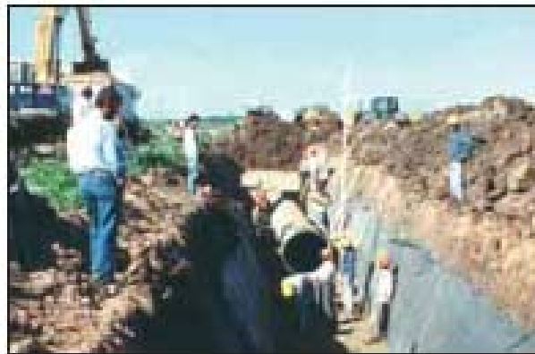
Acumulación de material cercano a la zanja
