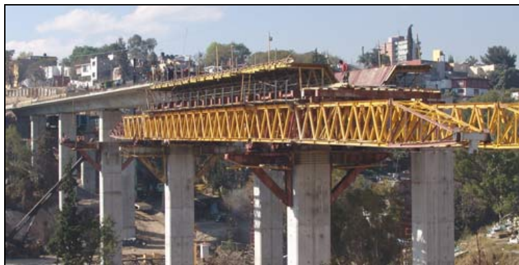
Estructura deslizante. Puente de Tarango (Méjico)
