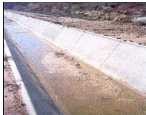
Daños por lluvias ocasionados en la construcción de un canal
