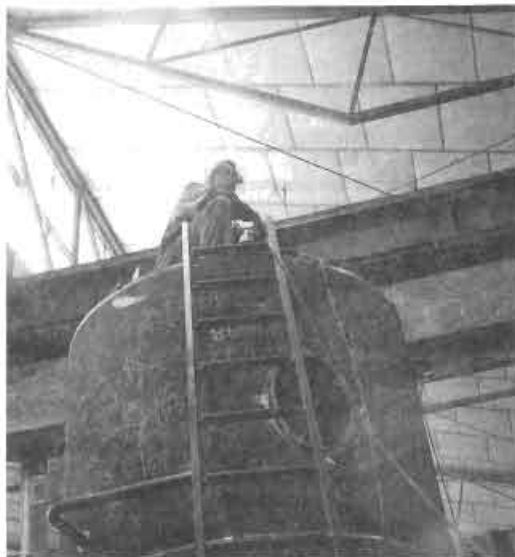
Fotos 38 y 39. Iluminación artificial y natural en sala de fabricación de calderas
