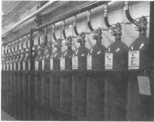
Foto 43. Sala de almacenamiento de halón
