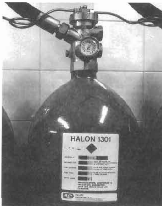
Foto 44. Detalle de botella de halón 1301 (Manómetro y etiquetas)
