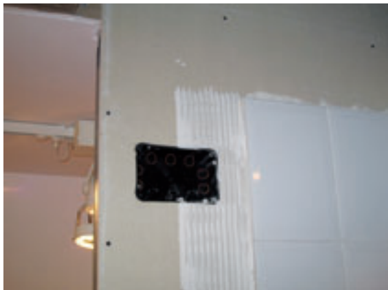
FIGURA 5.20. Acabado pendiente de colocación de cajas y mecanismos.
