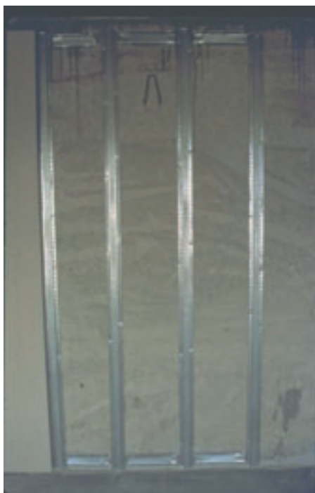
FIGURAS 5.11. y 5.12. Paneles industrializados con maestras metálicas 62 .
