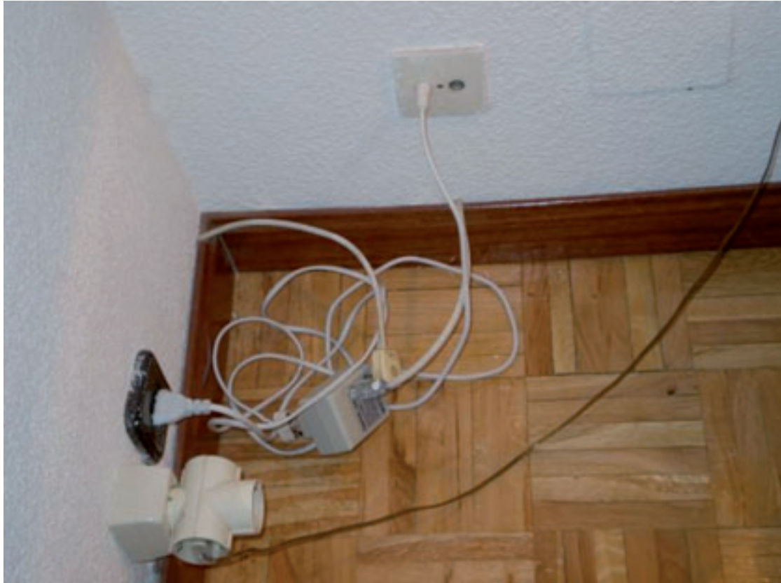
FIGURA 3.11. Punto de conexión de TV modificado para llevar la señal a otra estancia de la vivienda.
