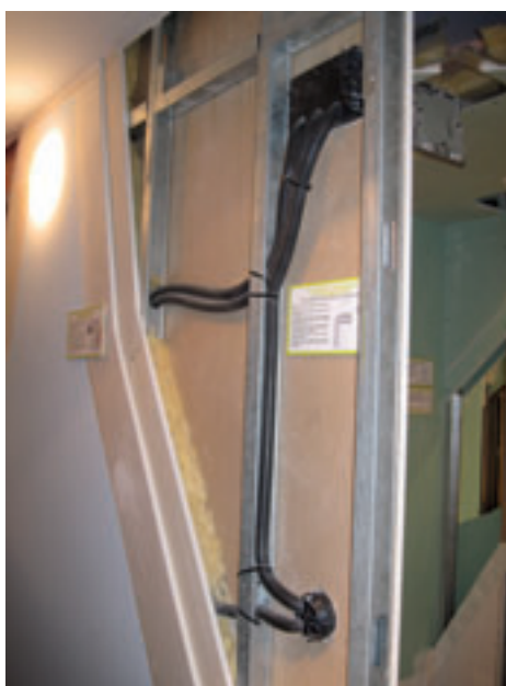
FIGURA 5.22. Colocación de placas e instalación.
