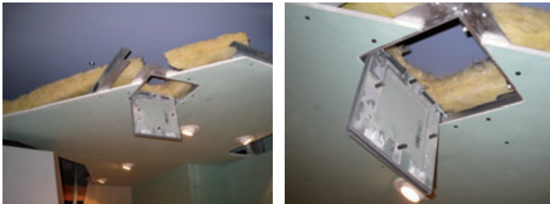
FIGURAS 5.6. y 5.7. Maqueta realizada con simulación de zona técnica en falso techo registrable 59 .
