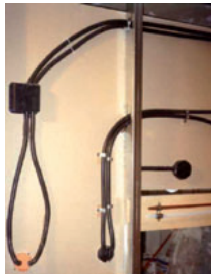
FIGURAS 5.15. y 5.16. Colocación de tubos por techo y pared.
