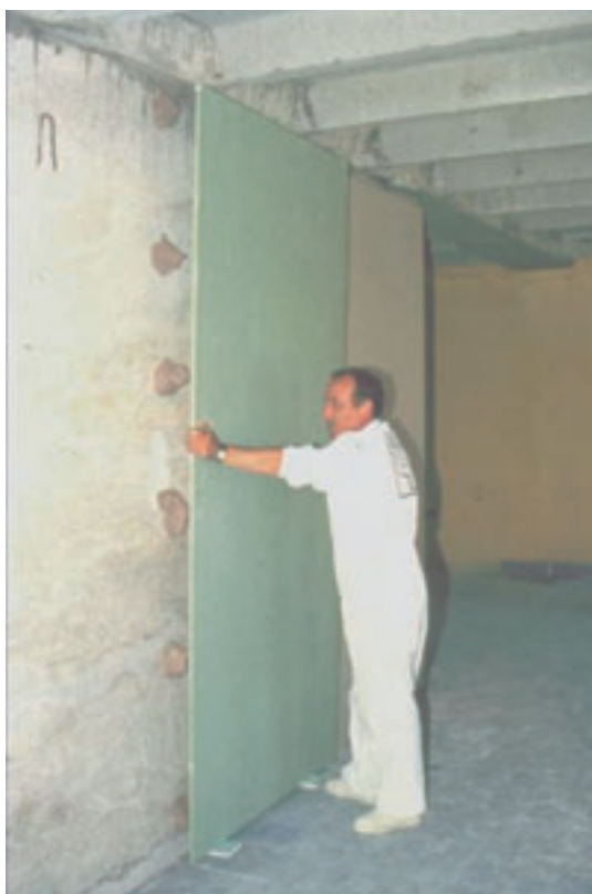
FIGURAS 5.9. y 5.10. Colocación de paneles industrializados.
