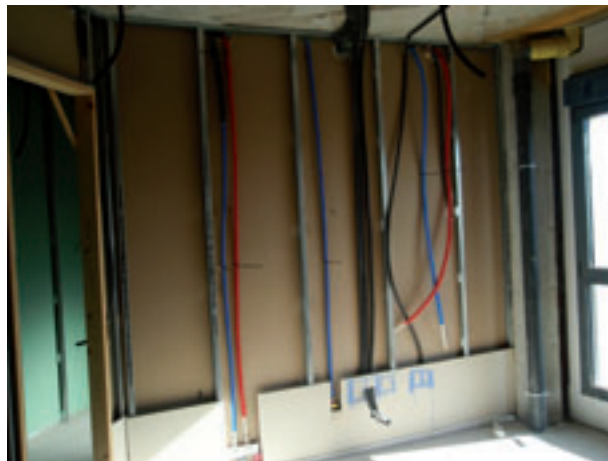
FIGURA 5.19. Marcado de ubicación de mecanismos.
