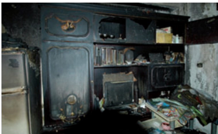
FIGURA 4.9. Incendio en salón de una vivienda 37 .
