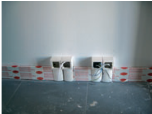
FIGURA 6.9. Detalle de las tomas de corriente y de TV.
