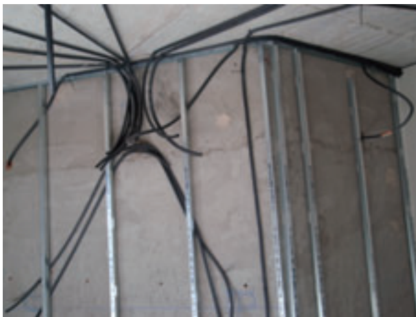
FIGURAS 5.15. y 5.16. Colocación de tubos por techo y pared.
