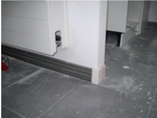
FIGURA 6.7. Detalle del terminal del zócalo portables. FIGURA 6.8. Tomas de corriente y de TV colocadas sobre el zócalo portables.
