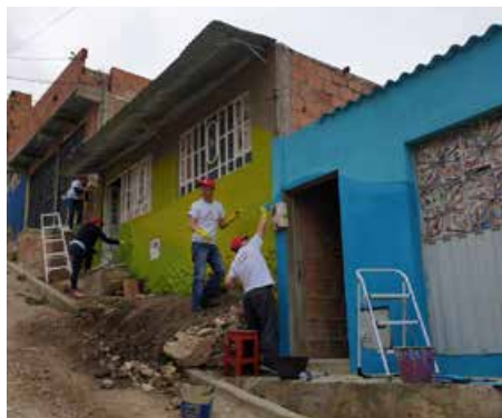
Nossos voluntários pintando a fachada das casas.
