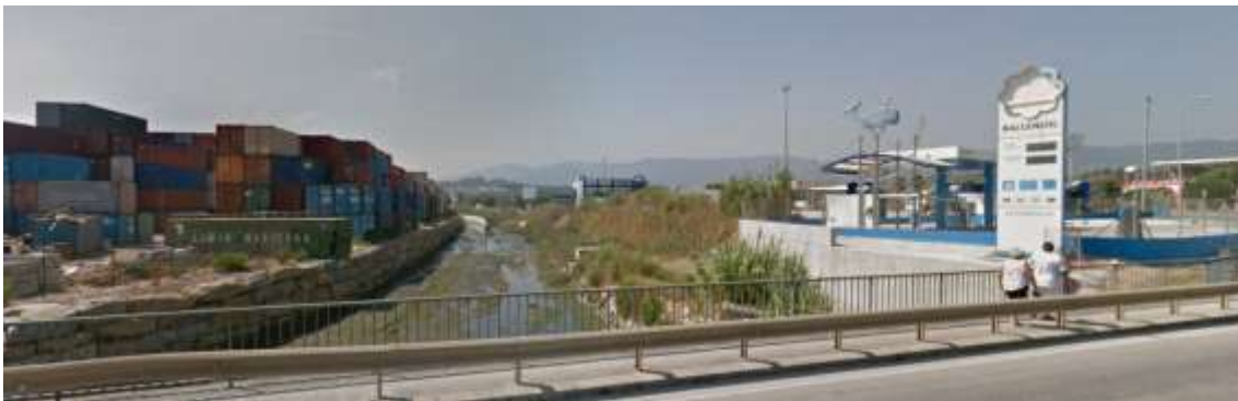
Ilustración 2: Cauce Cachón junto a la gasolinera (Fuente: google maps).
