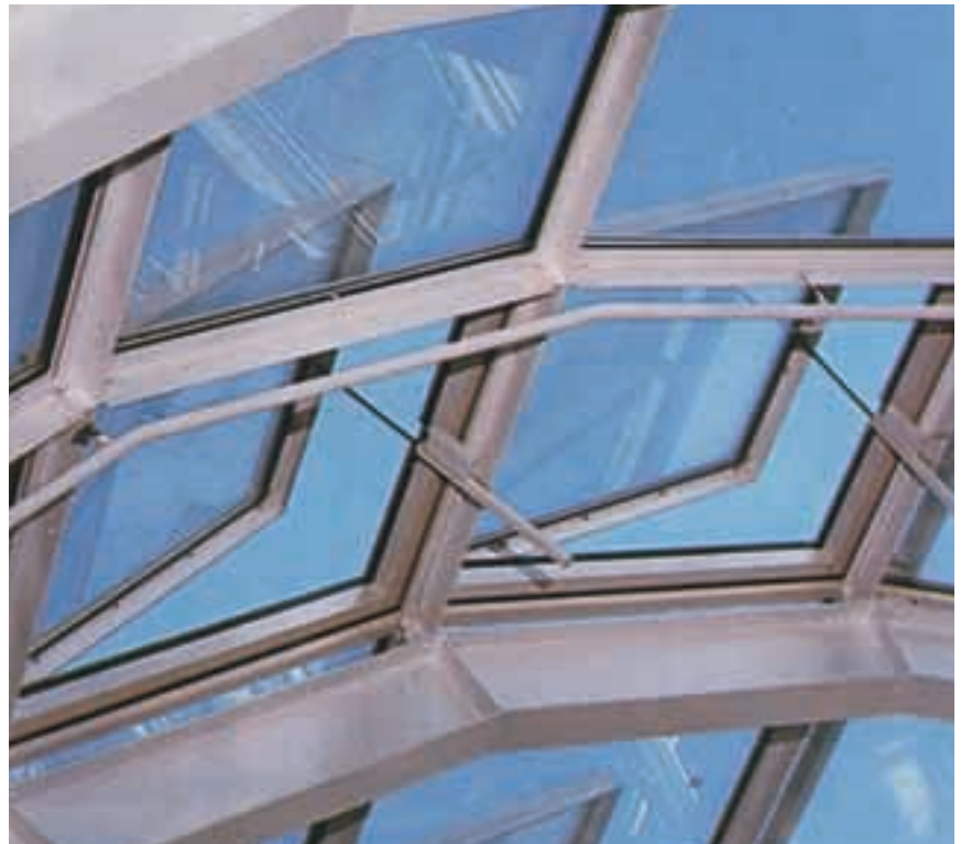
FIGURA 6. Empleo de dispositivos electromecánicos para la apertura de exitorios en un atrio. (Cortesía de D + H Mechatronics.)
