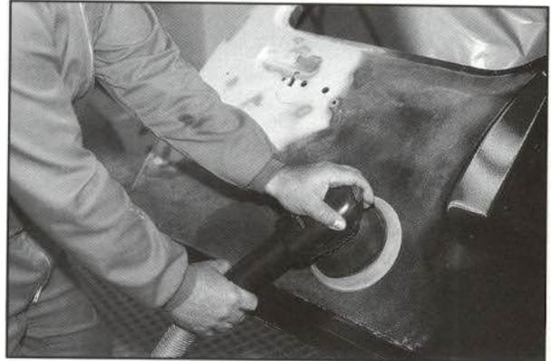
7. Tras una nueva limpieza y desengrasado, preparación del aparejo, siguiendo las instrucciones de mezcla que aconseja el fabricante, para recubrir y sellar la zona enmasillada. Este aparejo se aplica con pistola de gravedad en dos manos, respetando un tiempo de evaporación de 5 minutos entre mano y mano.
