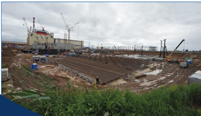
Rostov-4. Inicio de la construcción. (Foto: Rosenergoatom)
