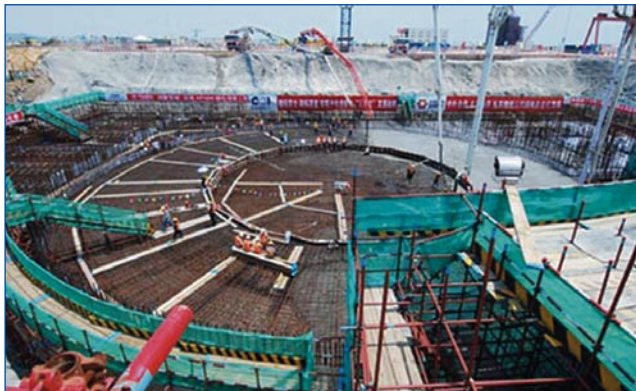
Hormigonado en Haiyang-2, China
