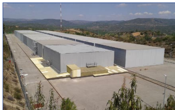
Centro de almacenamiento de residuos de El Cabril
