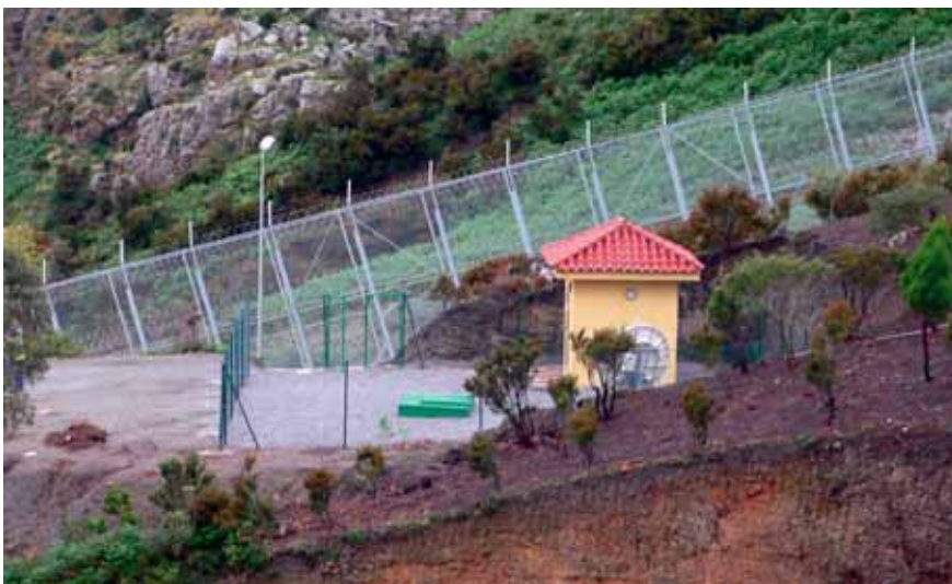
Instalaciones de la Red Sísmica Nacional en Ceuta.
