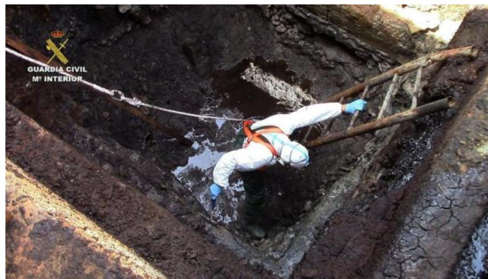
practicado sobre el terreno, sin impermeabilizar y repleto de residuos peligrosos en estado fangoso, cuyo contenido se estaba filtrando al subsuelo. ...
