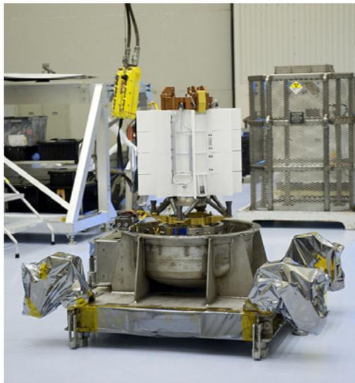
Proceso de montaje del MMRTG de la sonda que se envió a Marte en el Mars Science Laboratory.
