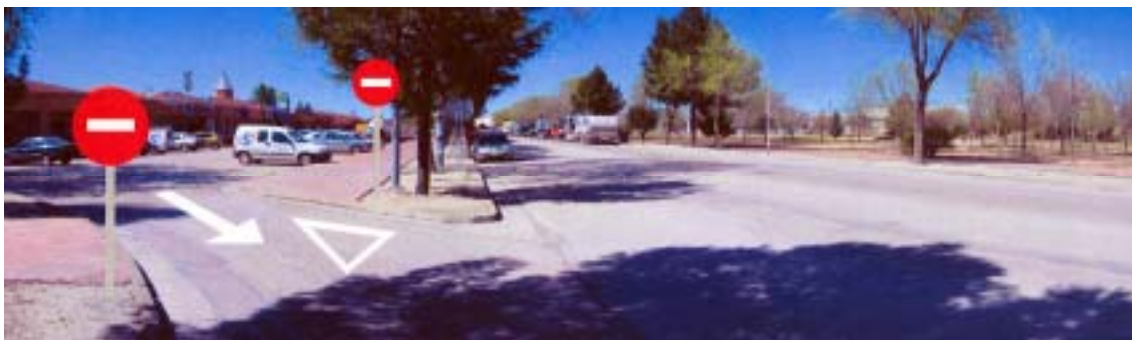
Vista panorámica de la salida (próxima a ADECA).
