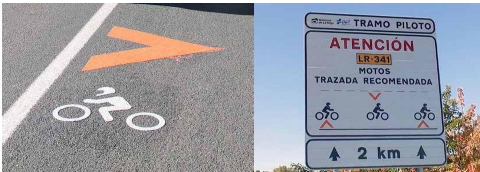
Figura 115: Teste-piloto de sinalização e marcações na via para melhorar o traçado das motos nas curvas.
