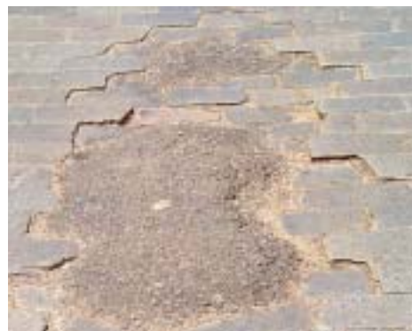
Pérdida de adoquines y baches reparados con aglomerado
