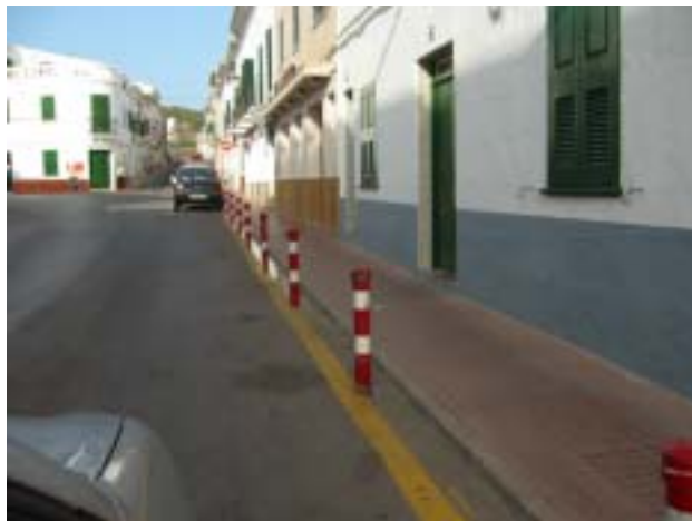
Bolardos junto a las aceras para impedir el aparcamiento sobre las mismas. Foto de Archivo AEC.
