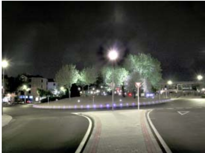
Glorieta con iluminación perimetral. Foto de Archivo AEC.
