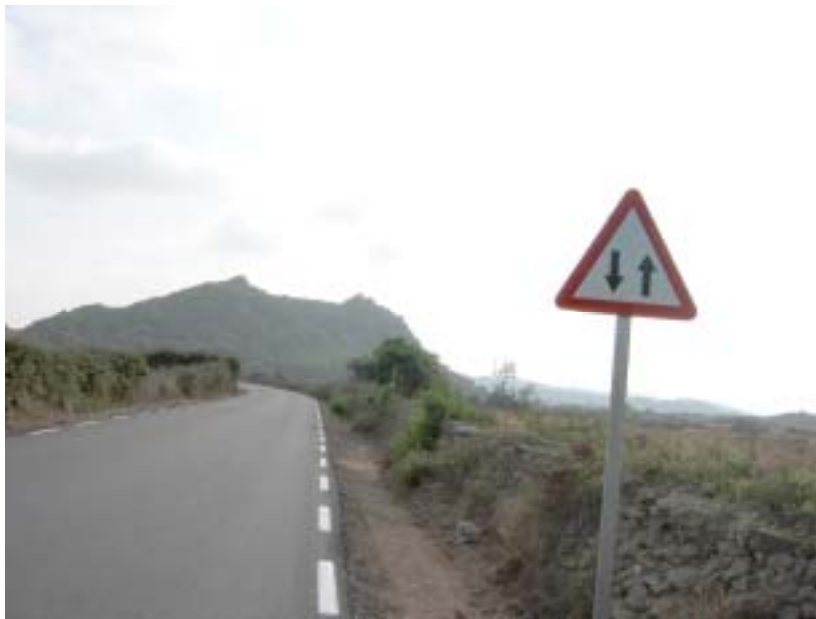
Señalización vertical en buen estado de conservación. Foto de Archivo AEC.
