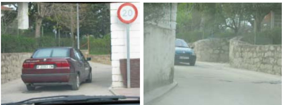
Vista anterior y posterior del mismo estrechamiento producido por la invasión parcial de una vivienda.
