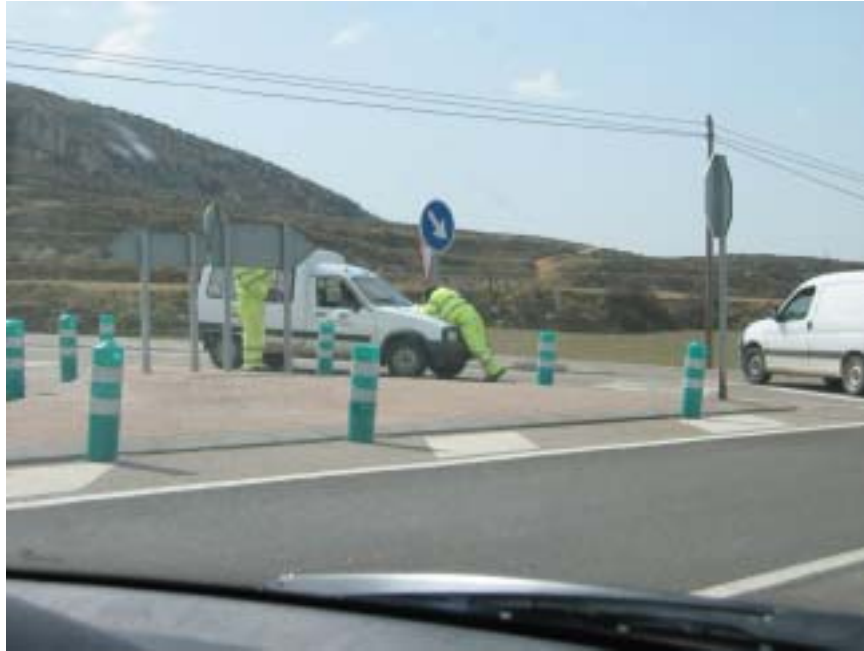
Personal de Conservación de Carreteras reponiendo balizas. Foto de Archivo AEC.
