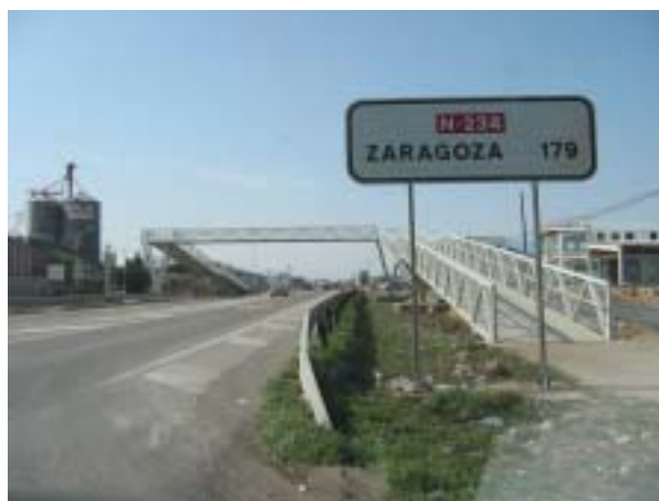
Paso elevado para peatones. Foto de Archivo AEC.
