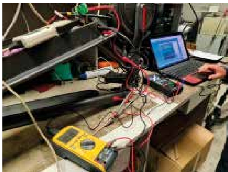
Figura 15. Comprobación de la tensión e intensidad de entrada durante la carga
