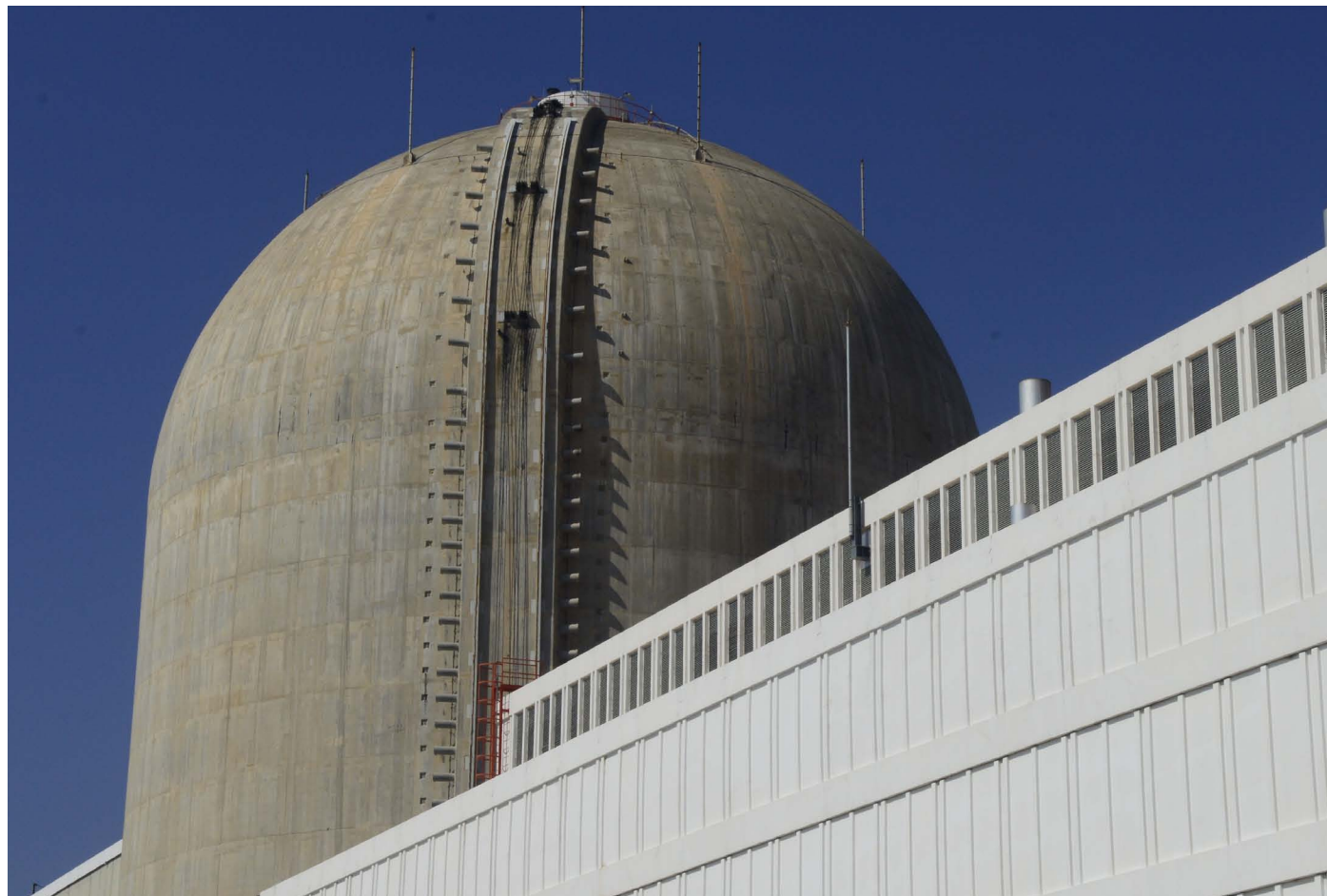
Edificio de contención de la central nuclear Vandellós II
