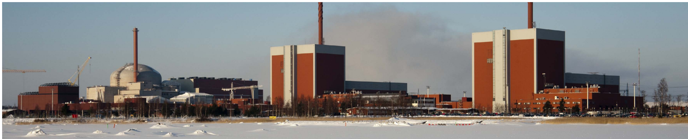
Central nuclear de Olkiluoto, Finlandia
