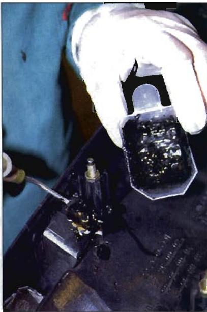
Aplicación de la argamasa para el refuerzo de la rotura.
