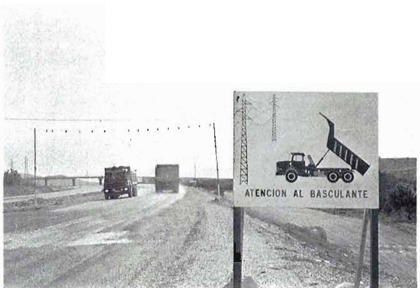
Pórtico de señalización en líneas de A. T.
