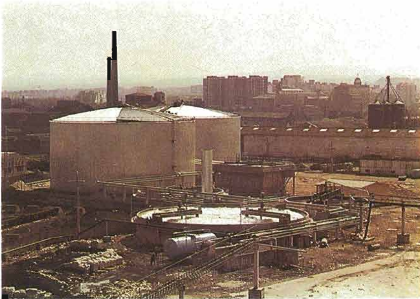
Planta de tratamiento anaerobio de los vertidos de una papelera con aprovechamiento del biogás producido.
