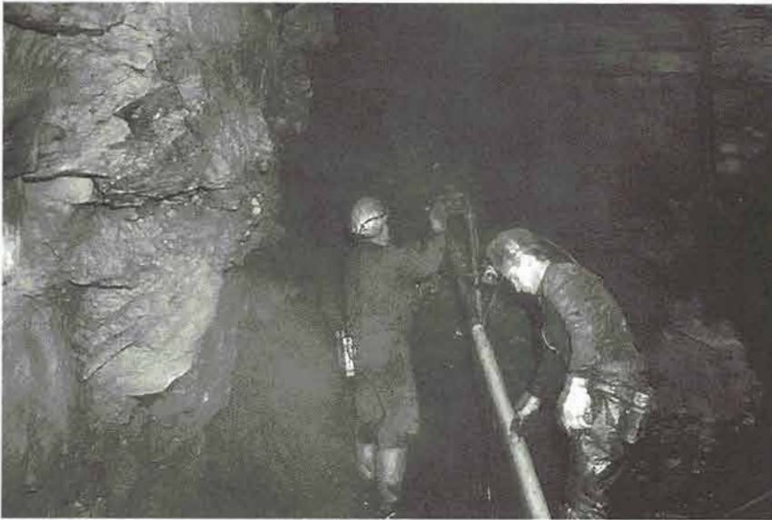
Barrenado con martillo de inyección de agua en una labor de preparación minera.
