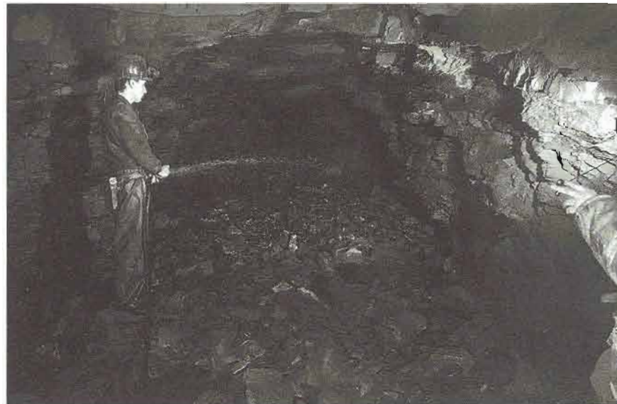
Riego del escombros con agua antes de su carga en los vagones.
